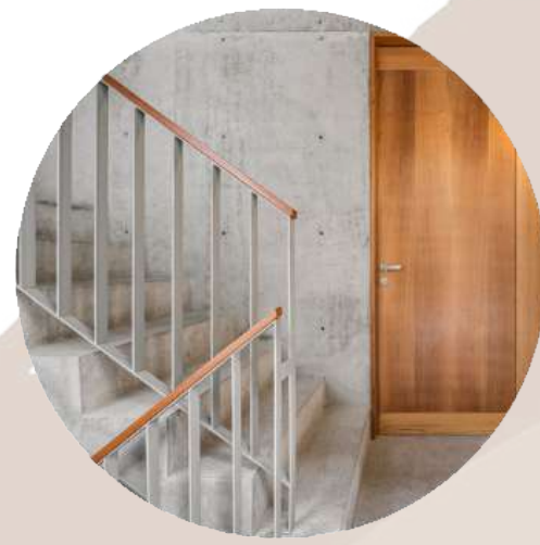
BARANDAL DE HERRERIA
